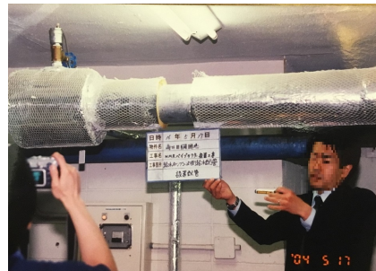
都内の大型分譲団地にNMRパイプテクターが取り付けられた工事の際の写真＝住民男性提供（写真は一部処理しています）
