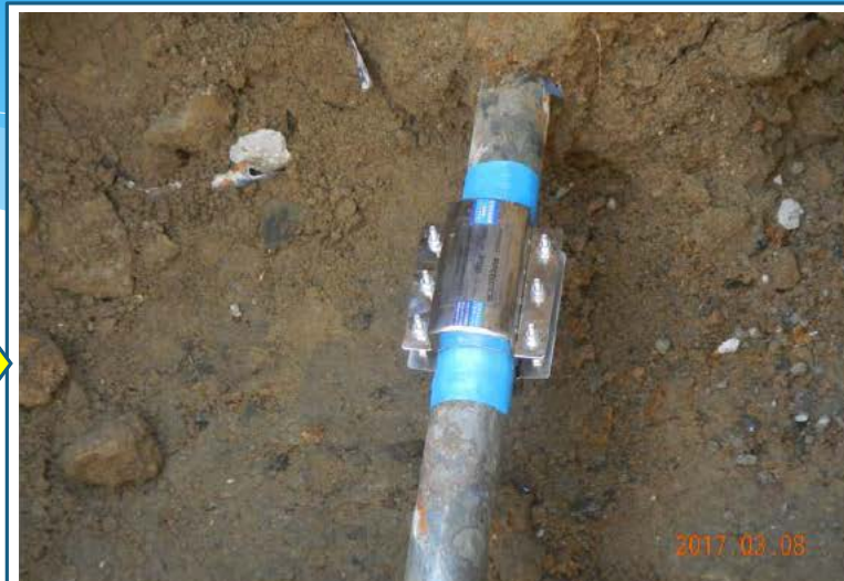
② 装置設置
