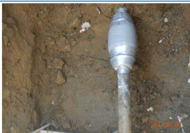
④ 保護シート設置完了
