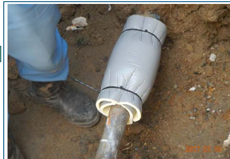
③ 保護シート設置
