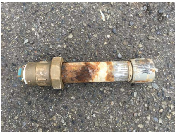
②下流側撤去管
