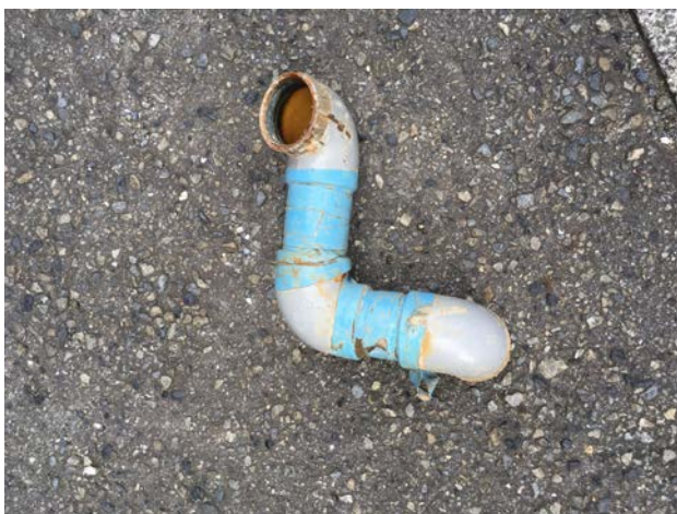
①上流側撤去管
