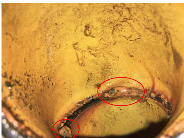
内面状況拡大
