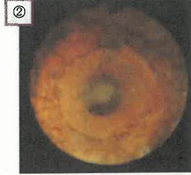
②402号室洗濯用水量器二次側 第二継手部(13A)
